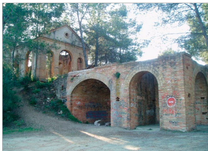
Figura 6. Concessió “Rosanes” (grup miner “La Martorellense”). Base del castellet del pou mestre. Foto: Frederic Varela.
