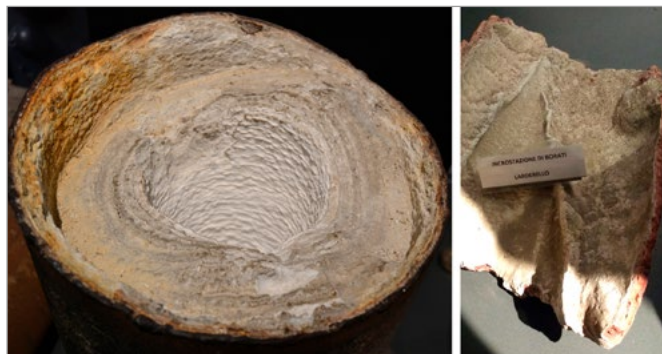
Museo della Geotermia, en Larderello: incrustaciones con sales bóricas, que acababan por embozar el interior de los tubos de conducción (de 1890). Foto: Jovita Ferrer.
