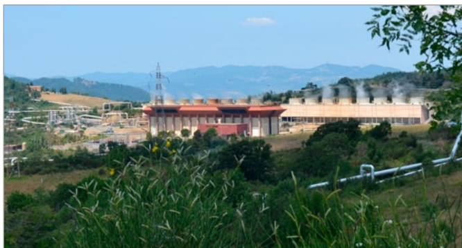
Central geotérmica 'Valle Secolo', junto a Larderello. Foto: Jovita Ferrer.
