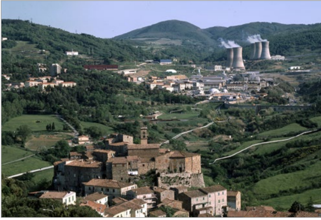
Montecerboli y, al fondo, Larderello con sus centrales geotérmicas 'Larderello 2' y 'Larderello 3'. Fuente: www.museivaldicecina.it .
