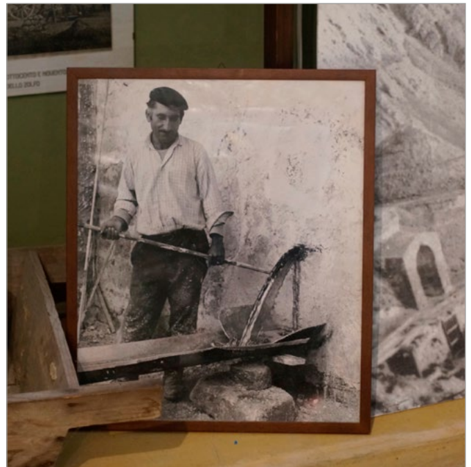
Fotografía de la preparación artesanal siciliana del azufre fundido. Utilizado por primera vez en Sicilia, de donde toma su nombre, el proceso siciliano se utilizó para obtener azufre de las rocas de las minas de la Zolfara. Los depósitos de azufre se apilan en hornos de ladrillo contruidos en pendiente y con espacios vacíos entre ellos. Después, el azufre en polvo se coloca sobre el depósito de azufre y se prende. A medida que el azufre se quema, el calor lo funde y fluye por la pendiente. El azufre fundido se recogía en bandejas de madera donde se enfriaba. Posteriormente, era purificado por destilación. Foto: Josep A. Ignacio.
